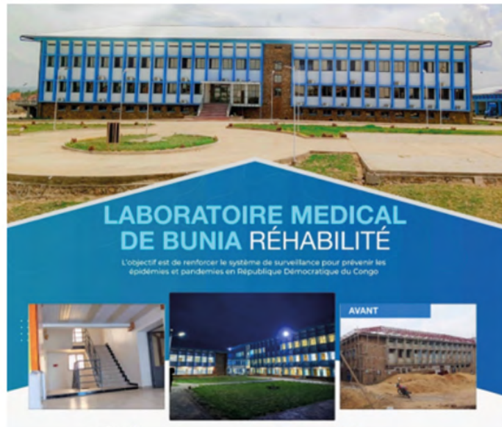
REDISSE IV - RDC : Réhabilitation et l'équipement du Laboratoire National de Santé Publique de Bunia
