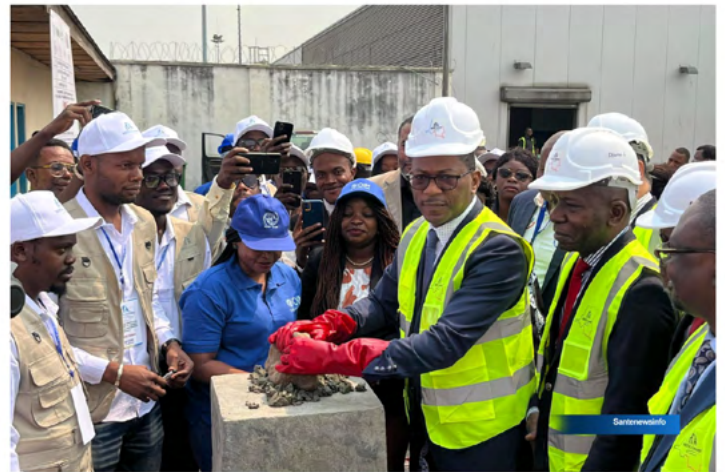
Pose de la première pierre là où les infrastructures seront construites.
